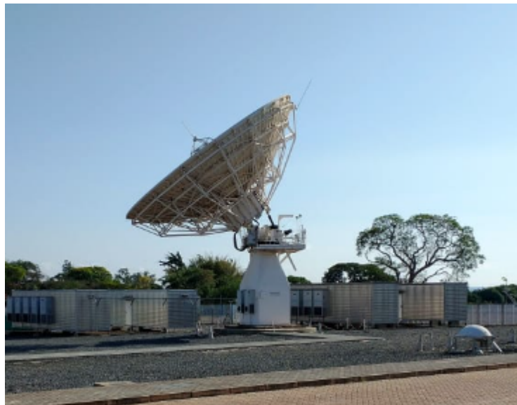
FIGURA 2.9 – Antena parabólica nas instalações do COPE em Brasília-DF. Fonte: Autor.
